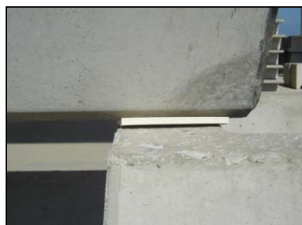
Figura 10: Vista laterale dell'appoggio
