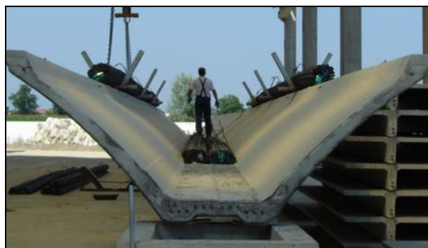
Figura 15: Vista del carico tegolo B
