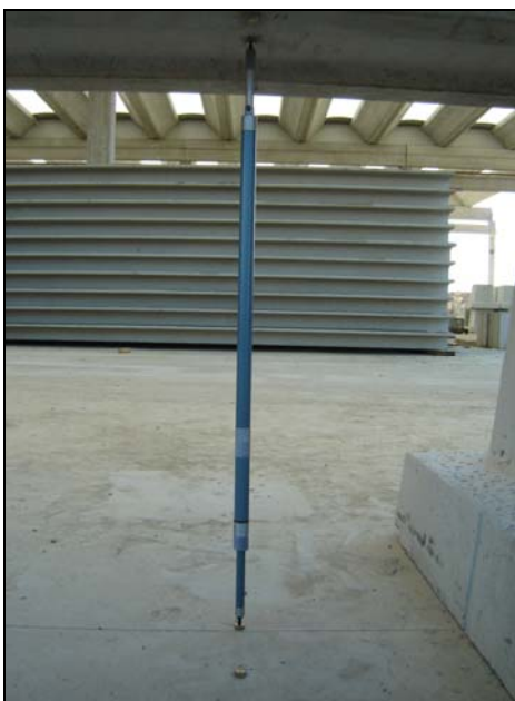
Figura 13: Misura degli abbassamenti
