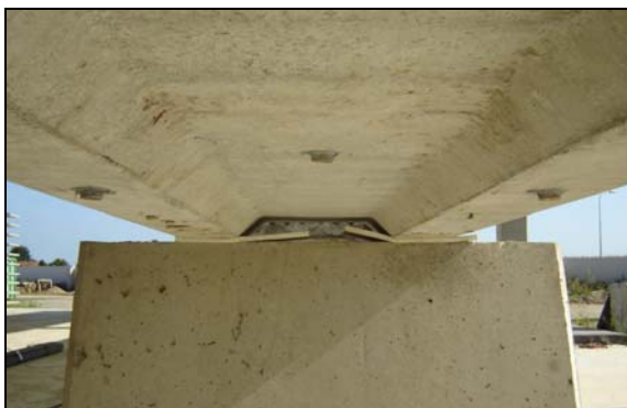
Figura 5: Vista delle basette posizionate in prossimità dell'appoggio
